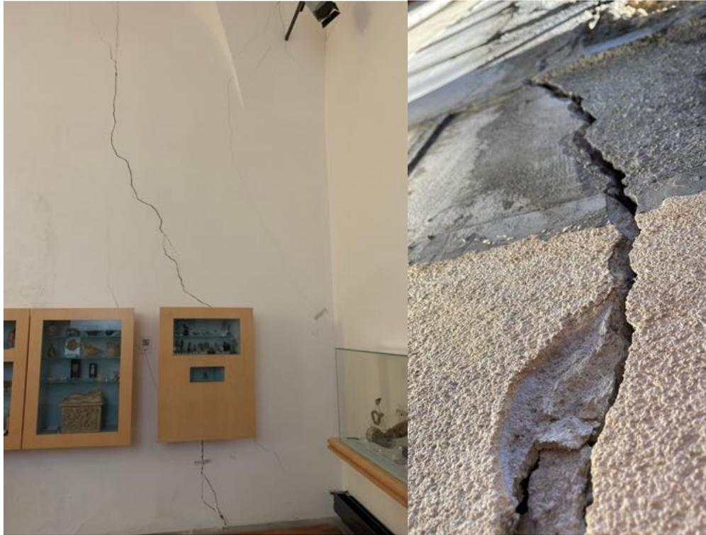
Figura 6 - Fessure rilevate nell'edificio del Museo Civico Antonio Collisani (a sinistra) e sulla parte esterna di un edificio lungo la strada di accesso al paese (a destra).
